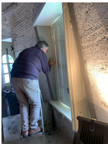
Stucwerk negge aanbrengen
