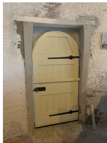
Binnenzijde voordeur is hersteld
